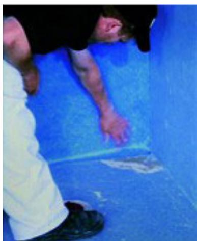
7. Der Dünnbettmörtel bzw. Fliesenkleber ist direkt auf die Abdichtbahn aufzubringen. Dabei ist zu beachten, dass die Fliesen in ein vollflächiges Klebebett verlegt werden. Welchen Fliesenkleber verarbeitet wird, hängt von den Fliesen ab die verlegt werden sollen. Unsere Empfehlung ist ein Dünnbettmörtel/ Fliesenkleber der die C2 Norm entspricht.
